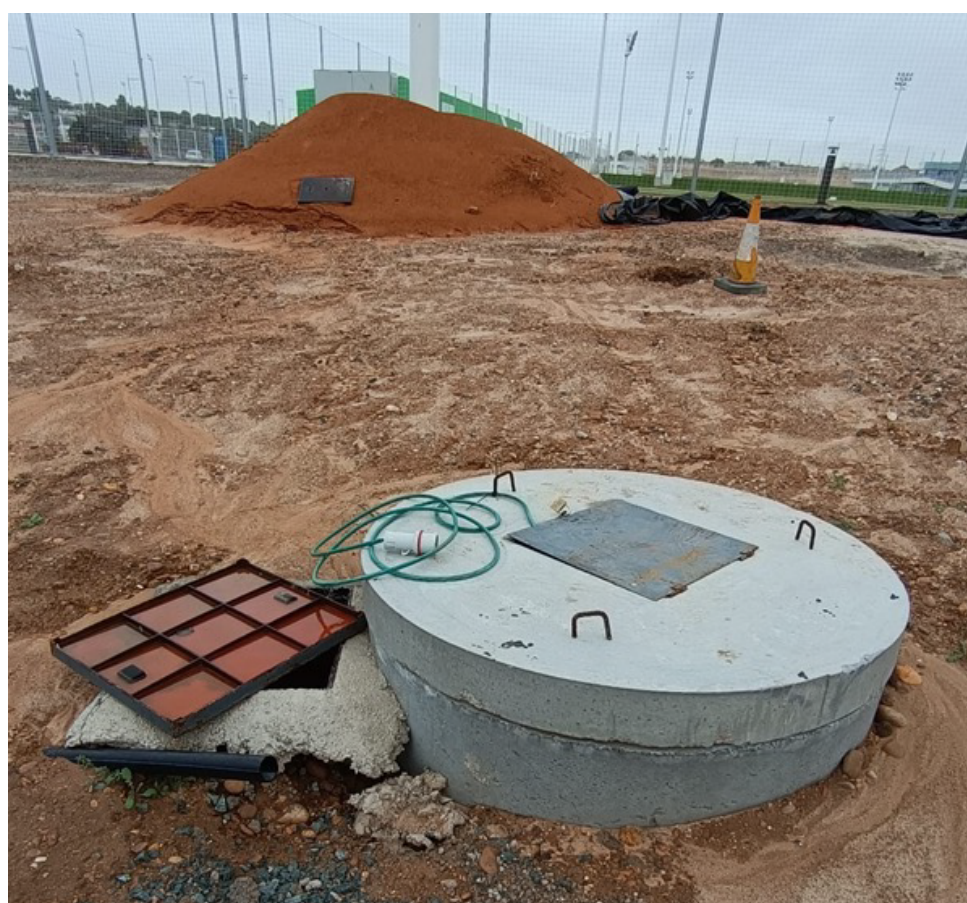
Figura 7 - Pozo para extracción de agua del subsuelo
