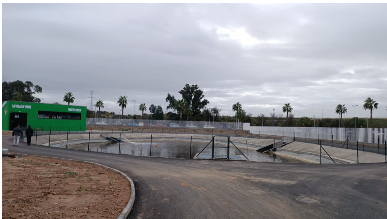
Figura 6 - Depósito de recogida de aguas pluviales, de drenaje de riego, y de agua de pozo
